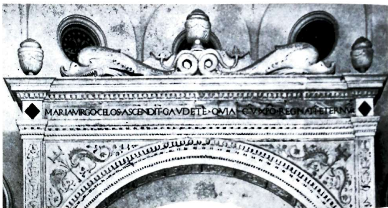
561 Ravenna, Altare dell'Assunzione in S. Maria della Croce a Ravenna (inquadramento architettonico dell'inizio del sec. XVI). "Frontone invertito" formato da un vaso tra due delfini; da notare anche le coppie di delfini affiancate a tridenti.
